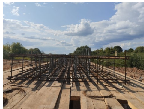
橋の再建工事の作業風景
