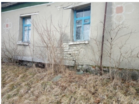
爆風で損傷したナロジチ病院
