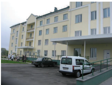
＜新築されたブルシロフ地区病院＞
