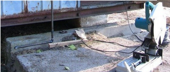
〈「ナロジチ病院水道工事」で活躍した、ねじ切り機〉
