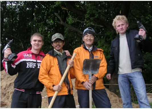
<右端がディーマ君(ラスキ村の工事現場にて)>
